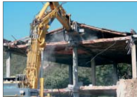
Le ruspe in azione durante la demolizione
